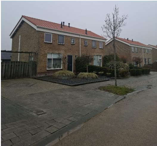
Renovatie gerealiseerd in St.-Annaparochie
